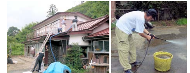
高圧洗浄による家屋の除染
