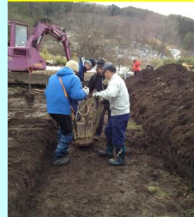
【までい工法1】汚染表土埋設法 表土剥ぎ取り+天地返し(2012.12.1)
