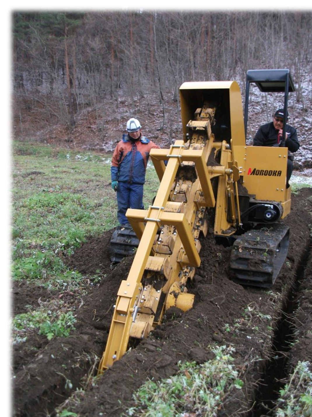
●暗渠用トレンチャーによる埋め込み溝の掘削試験 協力 株式会社 諸岡
