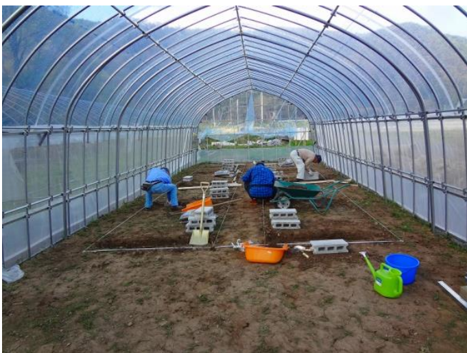
点滴栽培施設の基礎工事
