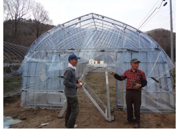
ハウスの被覆完成
