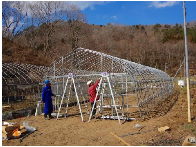
ハウスの骨組み完成
