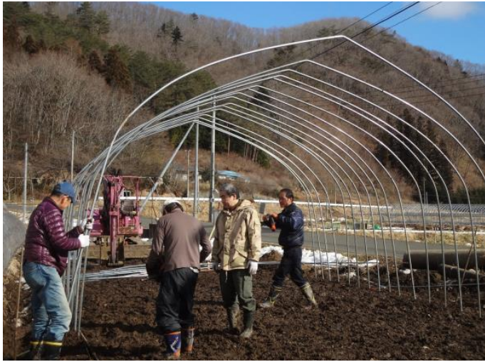
ハウスのアーチパイプ埋込み
