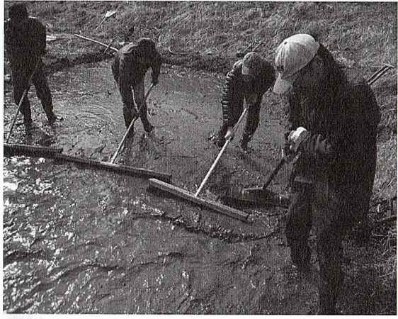
田に水を張って、放射性物質で汚染された表土を泥水状態にして洗い流し、地中に埋めて隔離する
