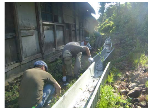
裏庭の排水路の整備
