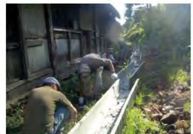
裏庭の排水路の整備
