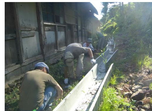
裏庭の排水路の整備
