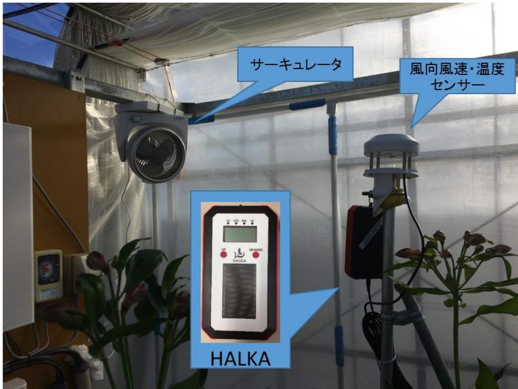
図 12 ハウスに設置された遠隔サーキュレータシステム。HALKA に接続された風向風速・温度センサーが 10 間隔でデータをクラウドサーバに送る。ユーザは携帯端末でデータを確認して必要に応じてサーキュレータのスイッチを ON/OFF する。
