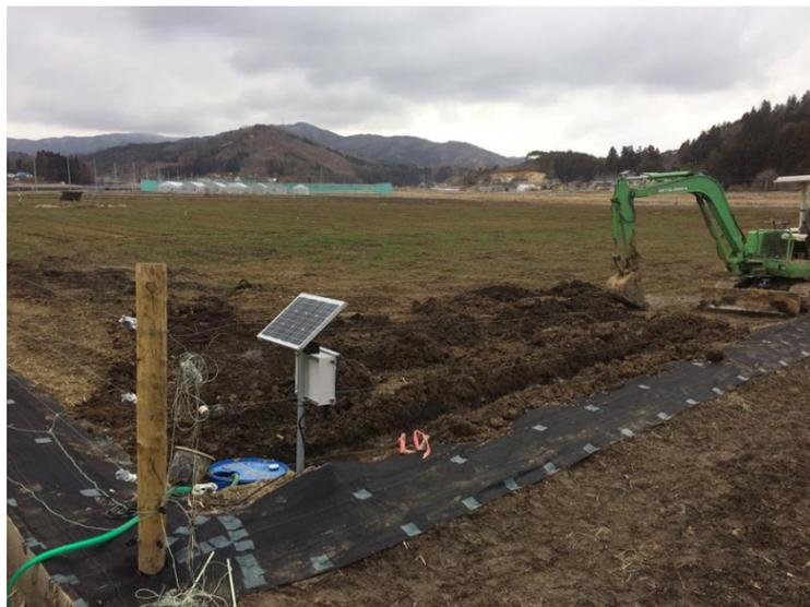
図 16 放牧地に設置されたソーラーポンプ排水システム。明渠に貯まった水の水位を検知し、HALKA を使って圃場外へ排出するポンプを遠隔で作動させる。
