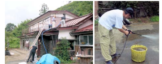
高圧洗浄による家屋の除染
