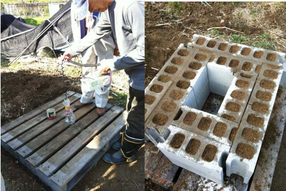
図 2 (左) パレットの設置。(右) コンクリートブロックの組み方 (1層目を組んだ所)
