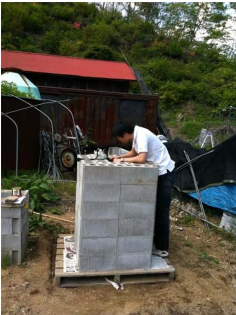
図 3 完成した遮蔽壁(高さ 114cm)
