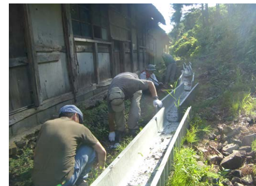
裏庭の排水路の整備
